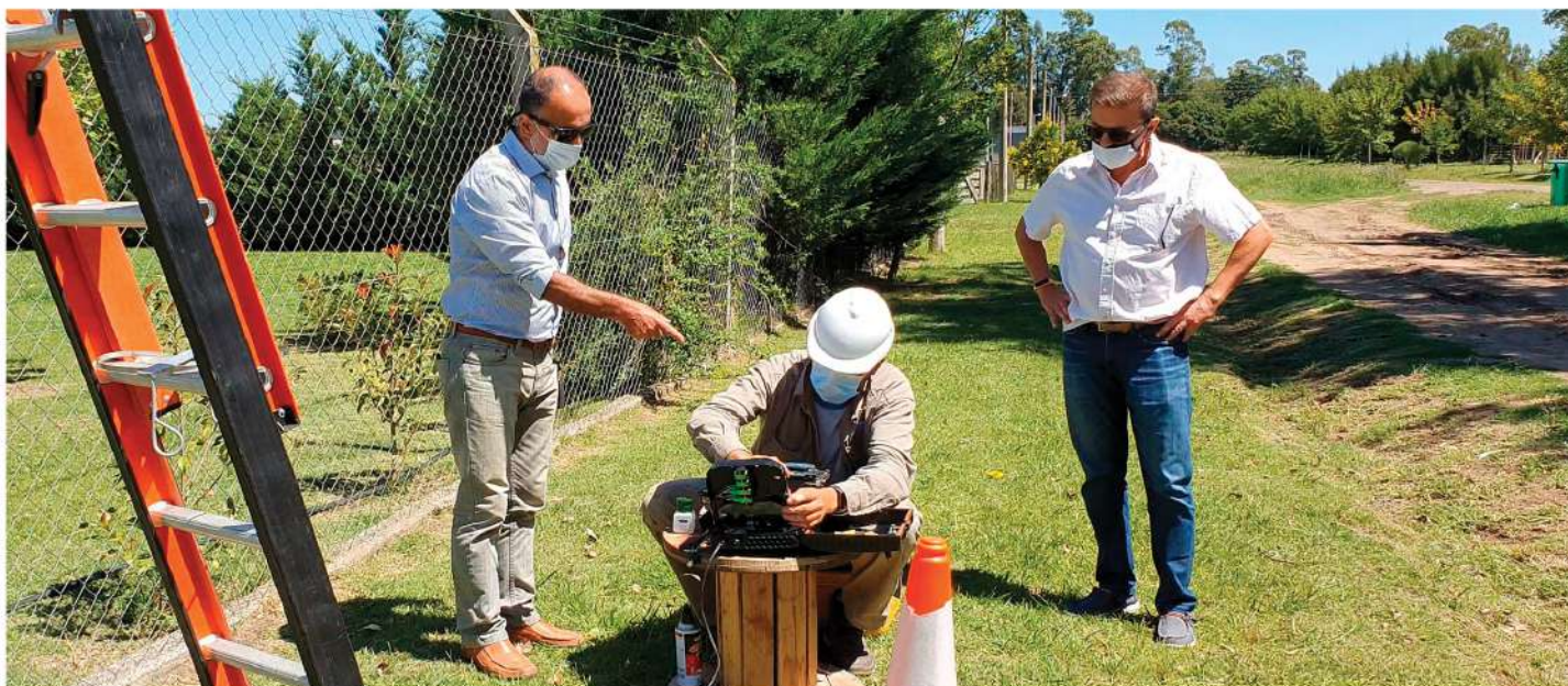
📷 Presidente de la CEM Lic. José Luis López junto al Asesor en Telecomunicaciones Ing. Juan Carlos Nounou, presentes en el recorrido por la obra en el Barrio Los Potreritos.
